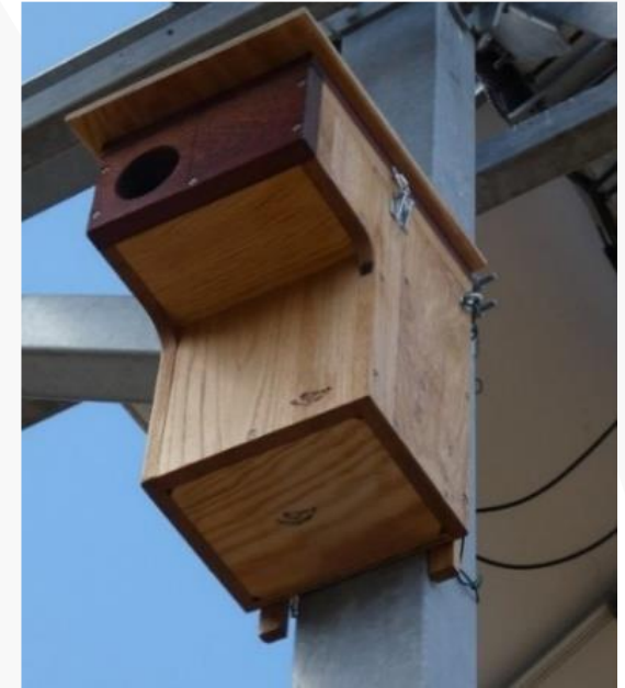
Installation de nichoirs artificiels pour la petite faune nicheuse
